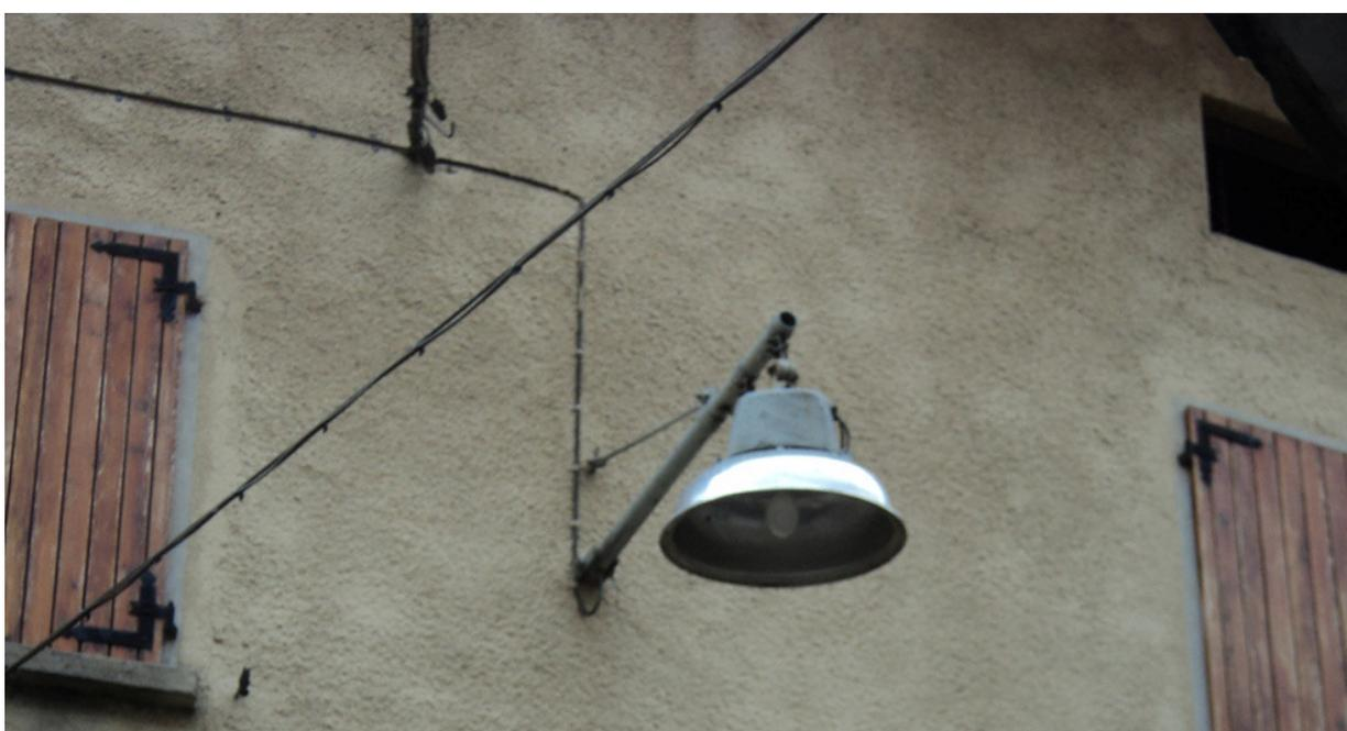
pessime condizioni e costituito da un semplice tubo estruso in ferro a cui è appeso il riflettore. Questo apparecchio è sempre dotato di lampade ai vapori di mercurio (poco efficienti e bandite dal mercato) e caratterizzato da rendimenti molto bassi. Alcuni esempi si trovano in via Rigamonte, via Baraccano, via Pertus.
