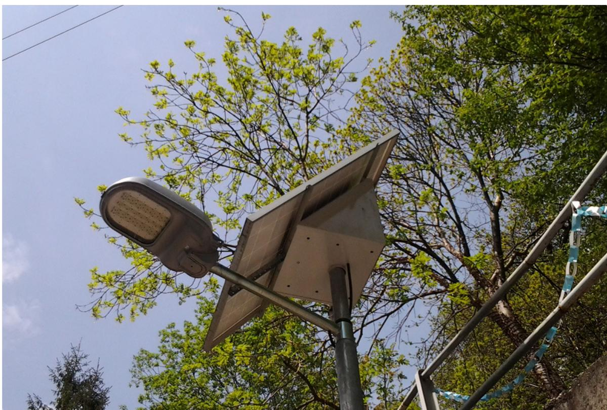
con pannello fotovoltaico: di questi dovrebbe comunque essere corretta l'inclinazione per evitare dispersione di flusso verso l'alto. Gli apparecchi d'arredo, anch'essi in buone o discrete condizioni, presentano comunque nella quasi totalità dei casi incompatibilità con la legge 17/2000 a causa dell'emissione di flusso luminoso verso la volta celeste. Da sottolineare è la totale assenza di lampade a vapori di mercurio installate in apparecchi di competenza del Comune.
