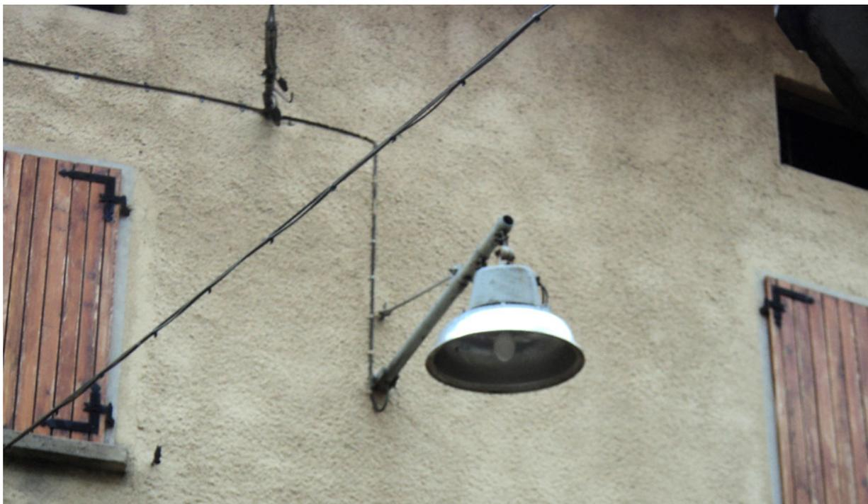
**Apparecchio privo di inclinazione e dispersione, ma solo parzialmente conforme perché privo di chiusura e con lampada a vapori di mercurio**
