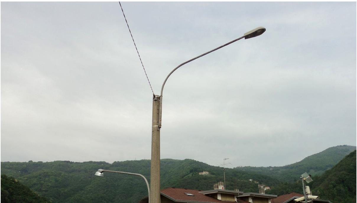
per l'illuminazione dell'area. Gli apparecchi di Enel Sole risultano in buona parte in pessime condizioni (137), montano lampade a vapori di mercurio (quindi con bassa efficienza) (167 su 198), spesso sono privi di vetro di chiusura (142) e solo in 13 casi non emettono flusso luminoso verso l'alto rispettando uno degli aspetti della
